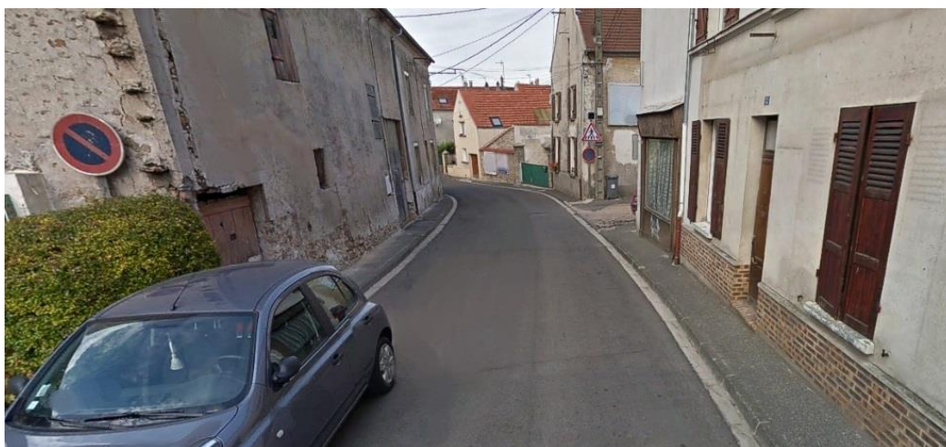
Figure 49 : Vue de la rue Jean-Jaurès dans le sens Sud-Ouest ⇒ Nord-Est montrant les caractéristiques à l'origine des difficultés de circulation dans ce secteur
