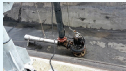
Réparation de la pompe
