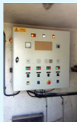
Changement tableau électrique
