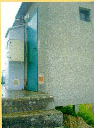
La station de pompage
