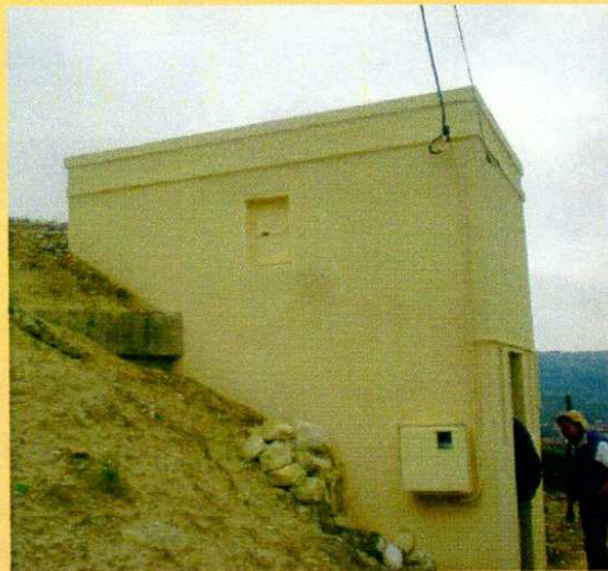
Le château d'eau
