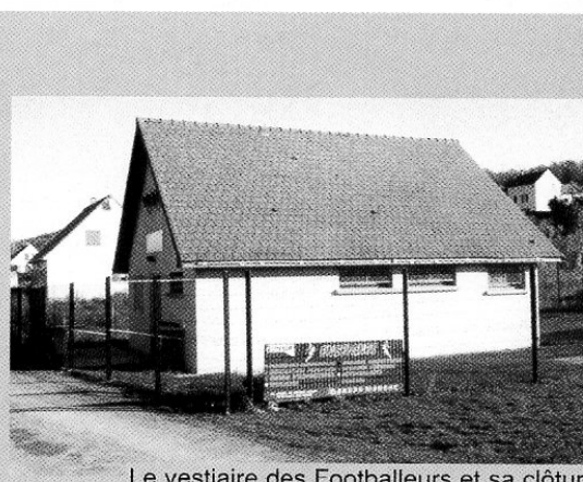
Le vestiaire des Footballeurs et sa clôture
