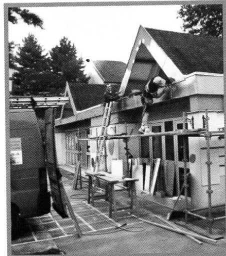
Réfection de l'étanchéité de la toiture 4 e classe
