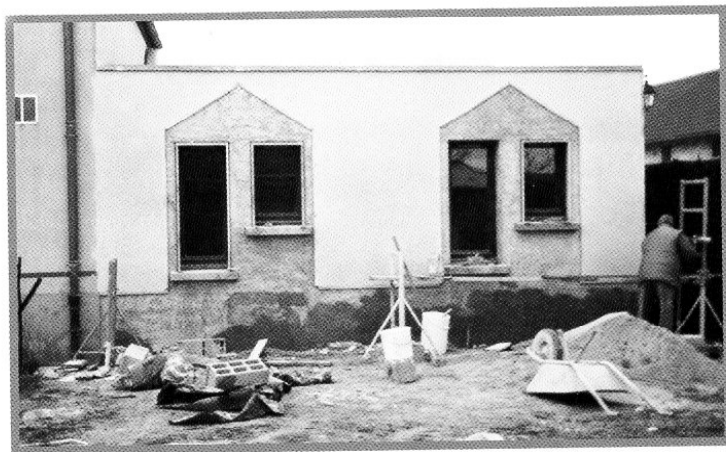
Aménagement du local matériel à la salle du Clos des Forges
