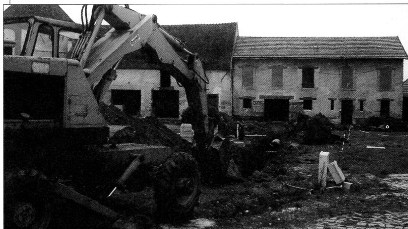
Pose des réseaux EAU ASSAINISSEMENT PLUVIAL 1 ère tranche
