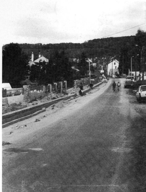
Travaux route de Pisseloup
