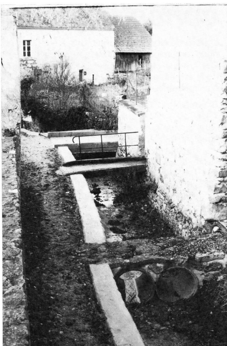
Travaux dans le ru des Geais.
